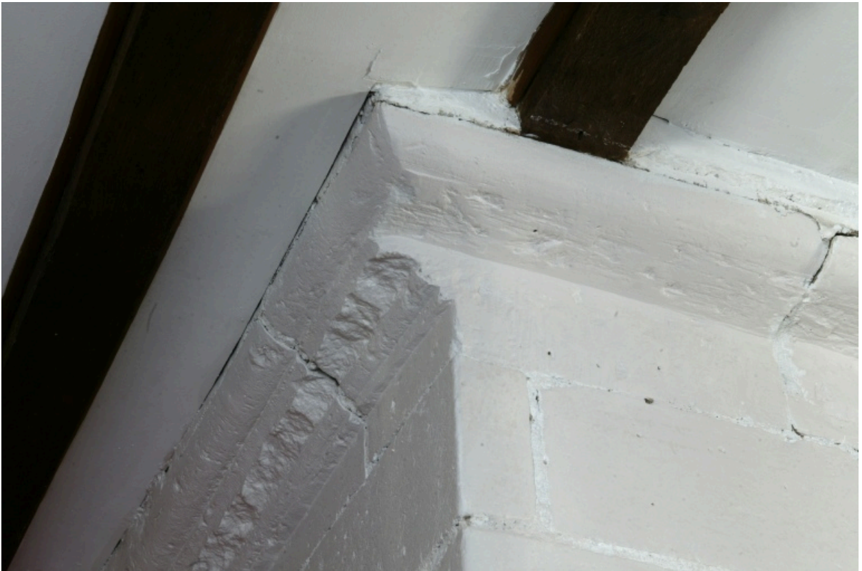
Cheminée sud du deuxième étage, détail de la corniche.
