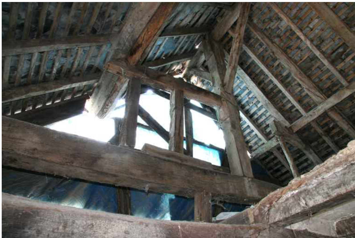
Maison 1 : la charpente.
