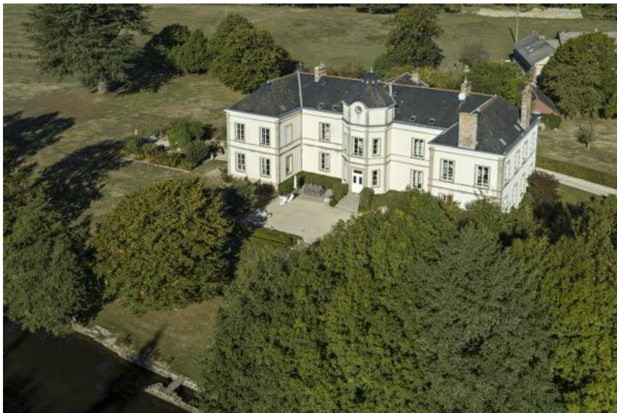
Château vu du nord-est.
