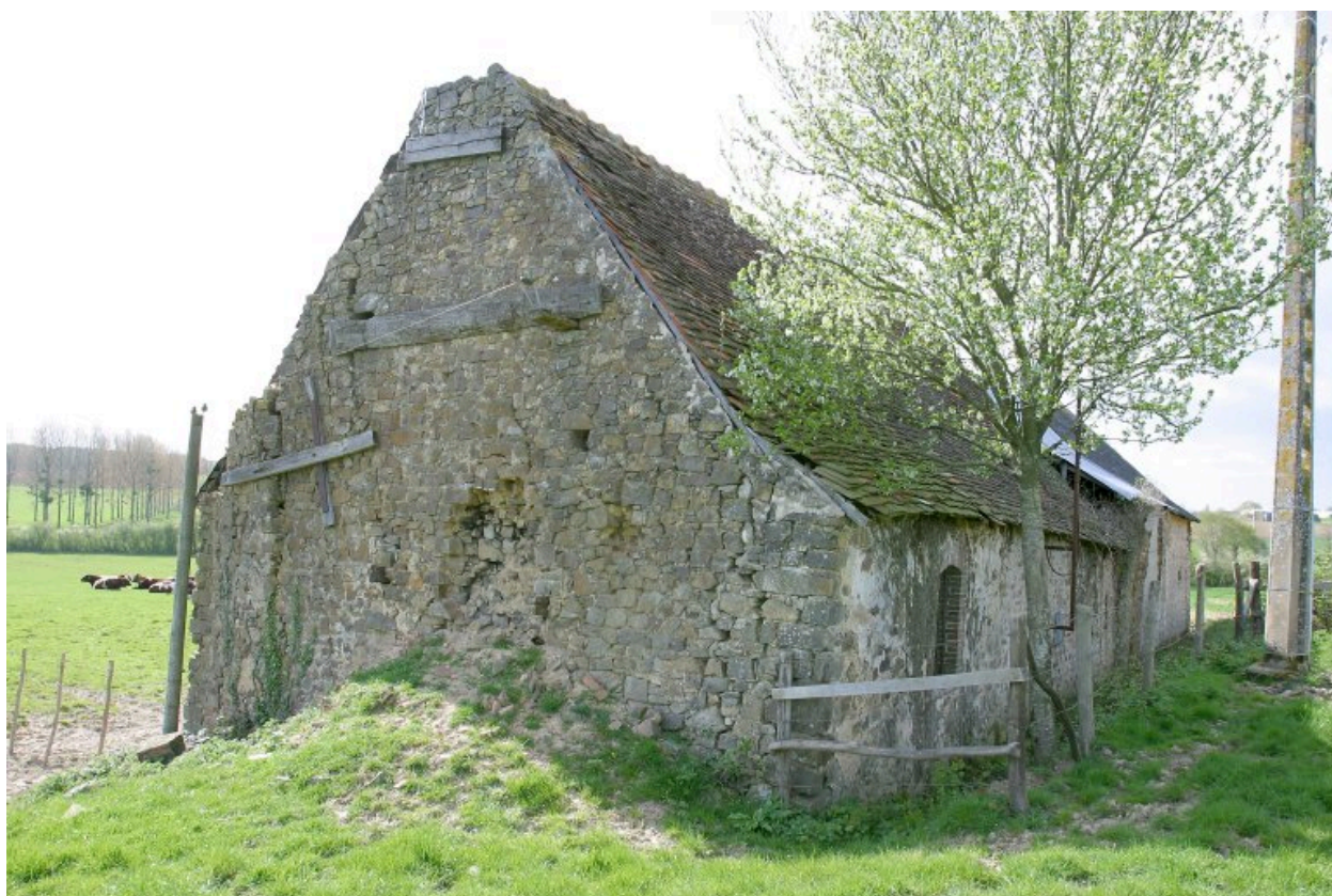
Le pignon sud-ouest et la façade arrière.
