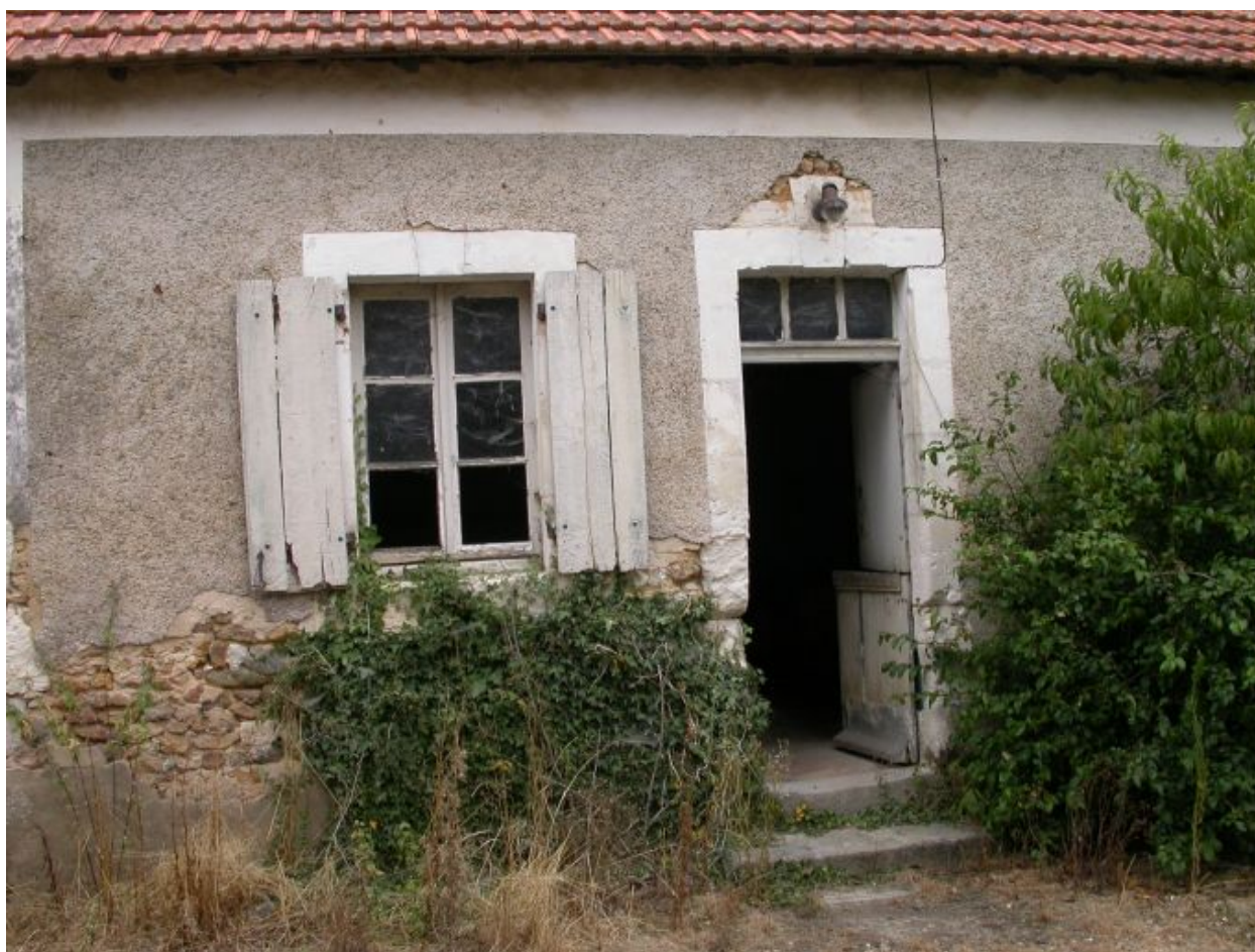
Bâtiment n° 1 : façade de l'habitation.
