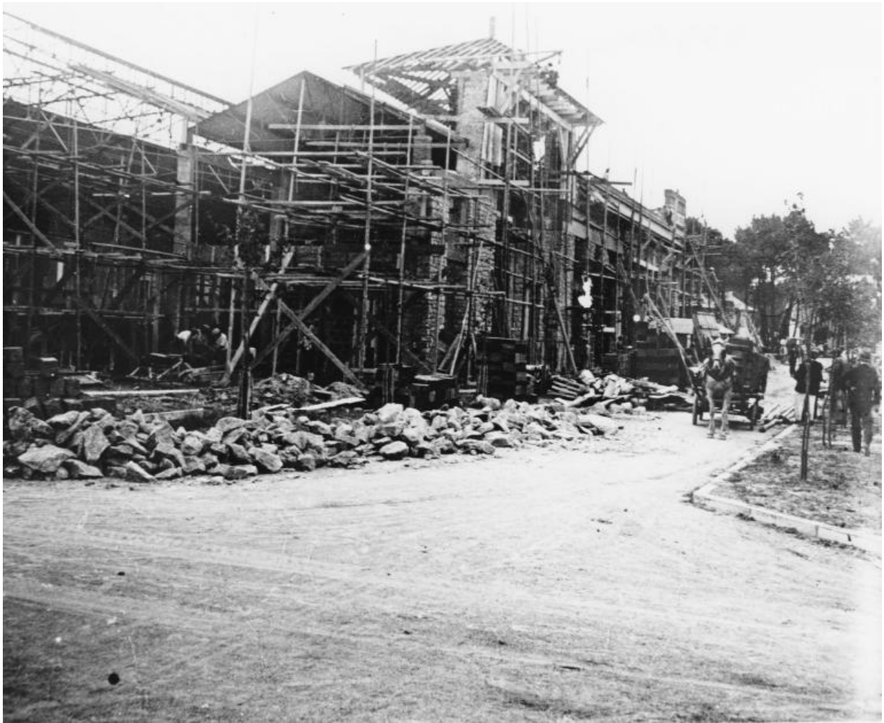
Portail ouest du garage Citroën en construction en 1928.
