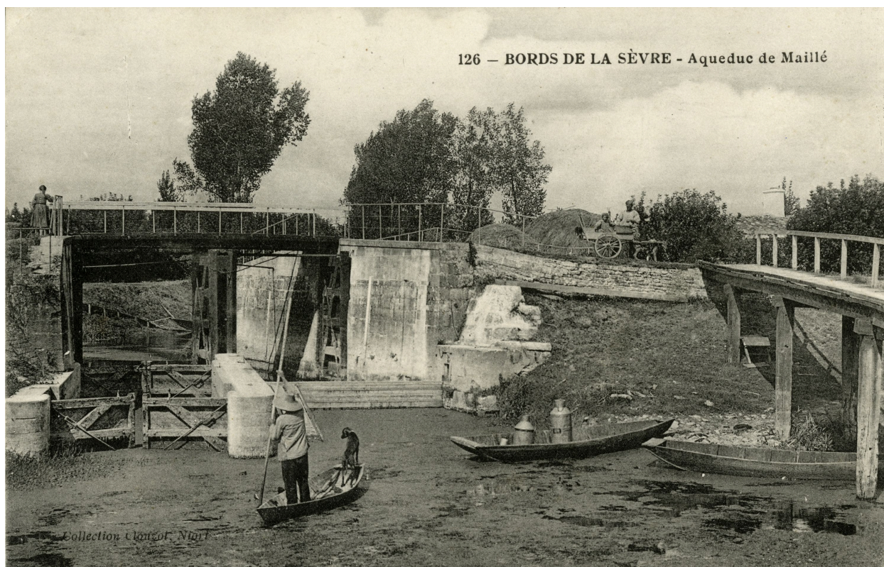
L'aqueduc de Maillé vu depuis l'aval vers 1910, avec ses portes en bois et, à droite, la maison du garde.
