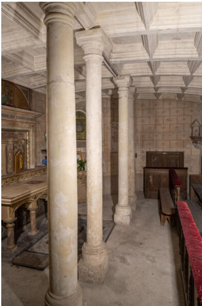
Chapelle basse : vue d'ensemble depuis le nord.
