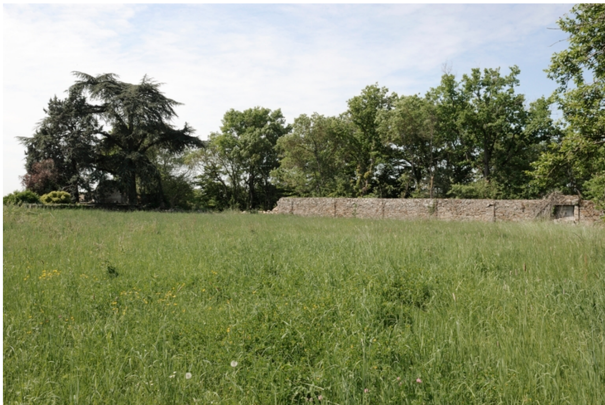
Vue du mur de clôture.
