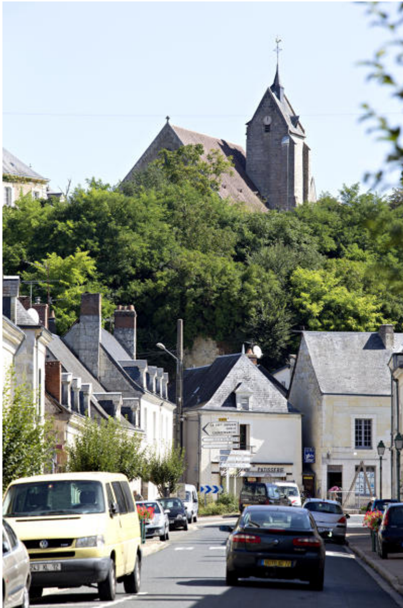
Poncé-sur-le-Loir, rue Principale que surplombe l'église paroissiale Saint-Julien.
