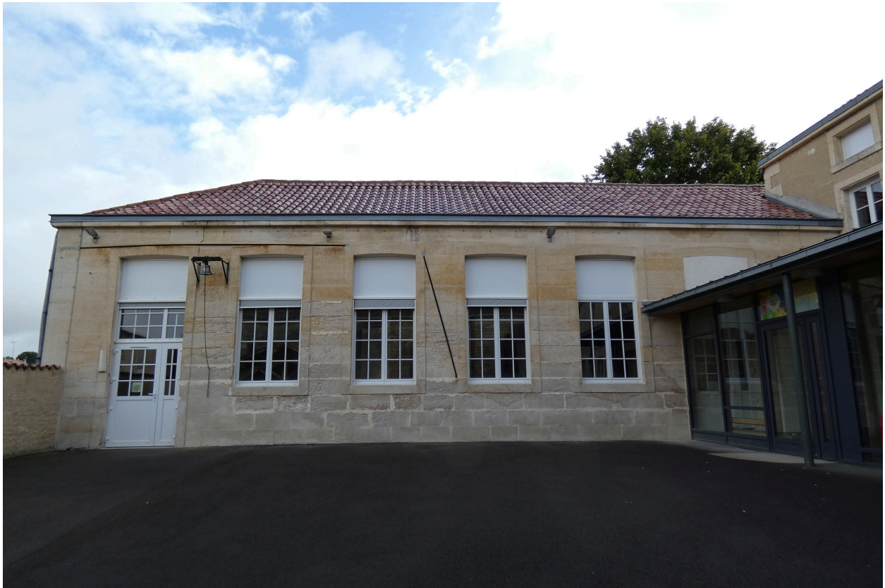
Le bâtiment de classes, au nord de la cour, vu depuis le sud.
