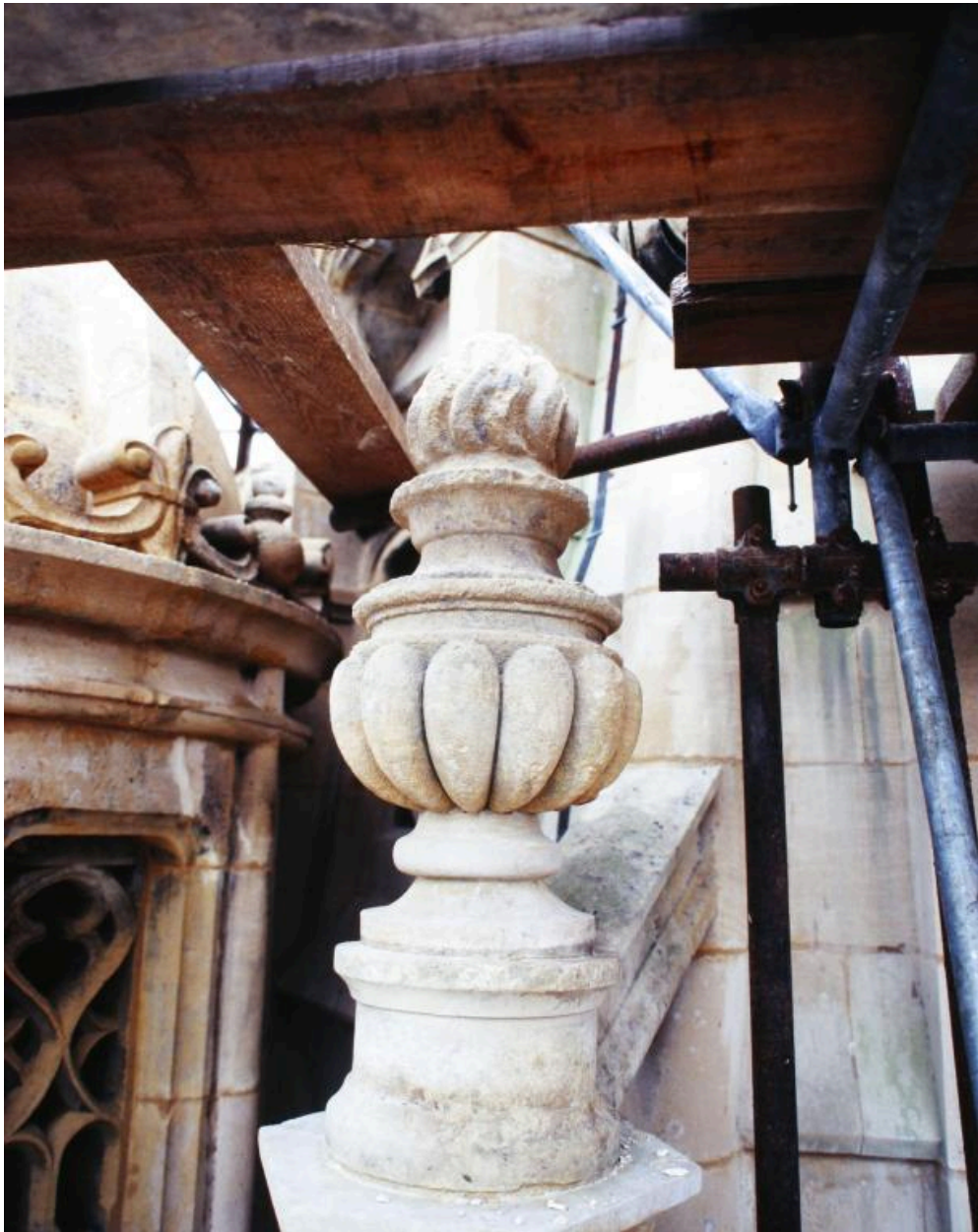
Basilique, clocher : détail ornemental, pot à feu.
