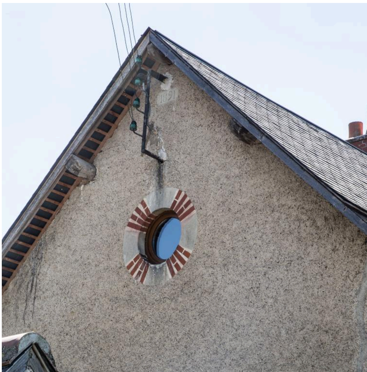
Ferme non étudiée, pignon, détail : date portée 1891.
