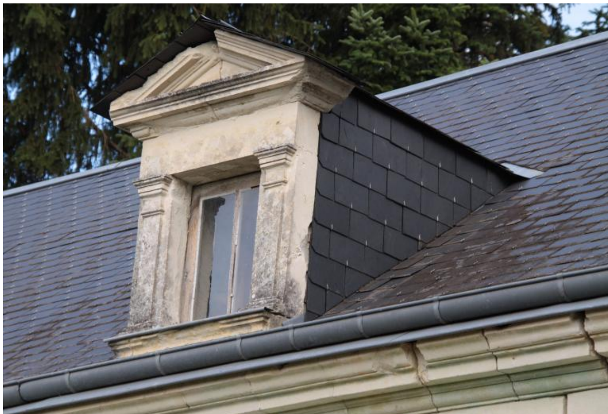
Détail d'une lucarne.
