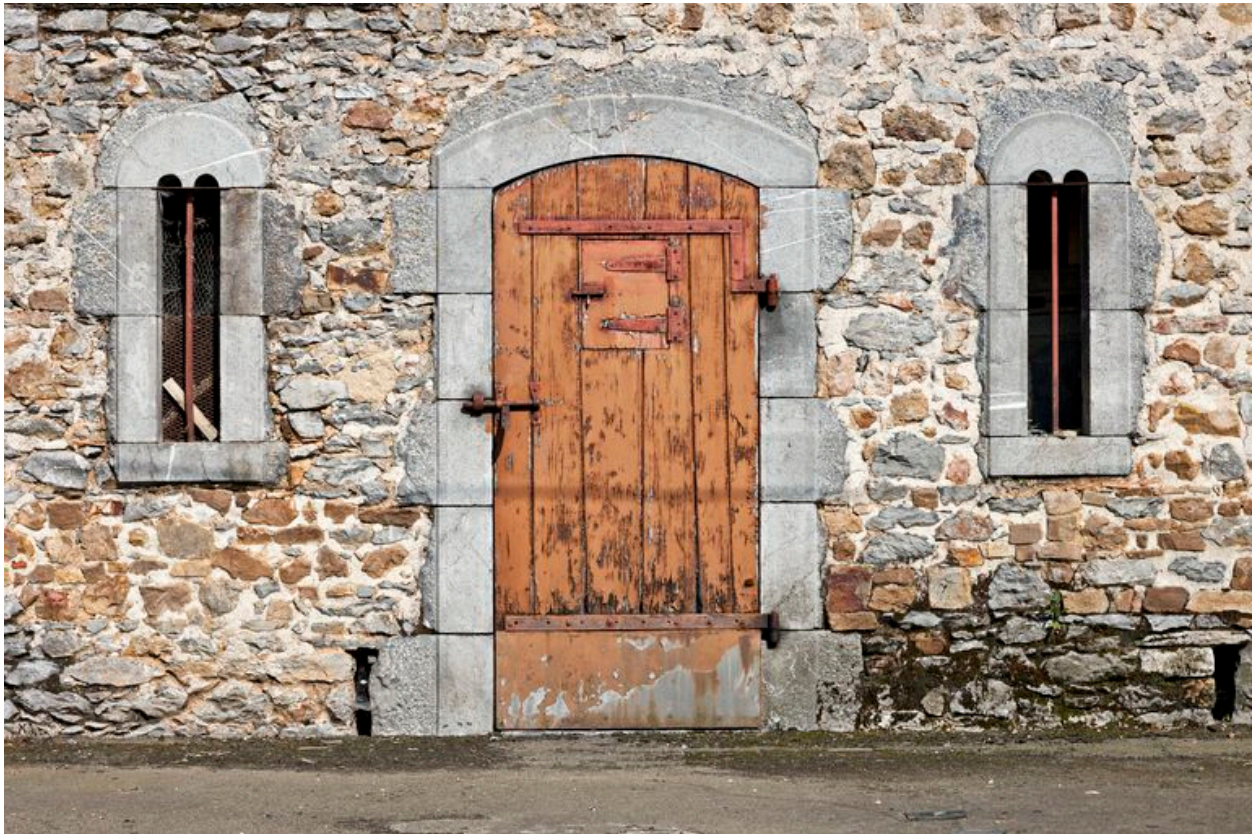
Ferme ouest, vue de détail de la porcherie : porte et jours.
