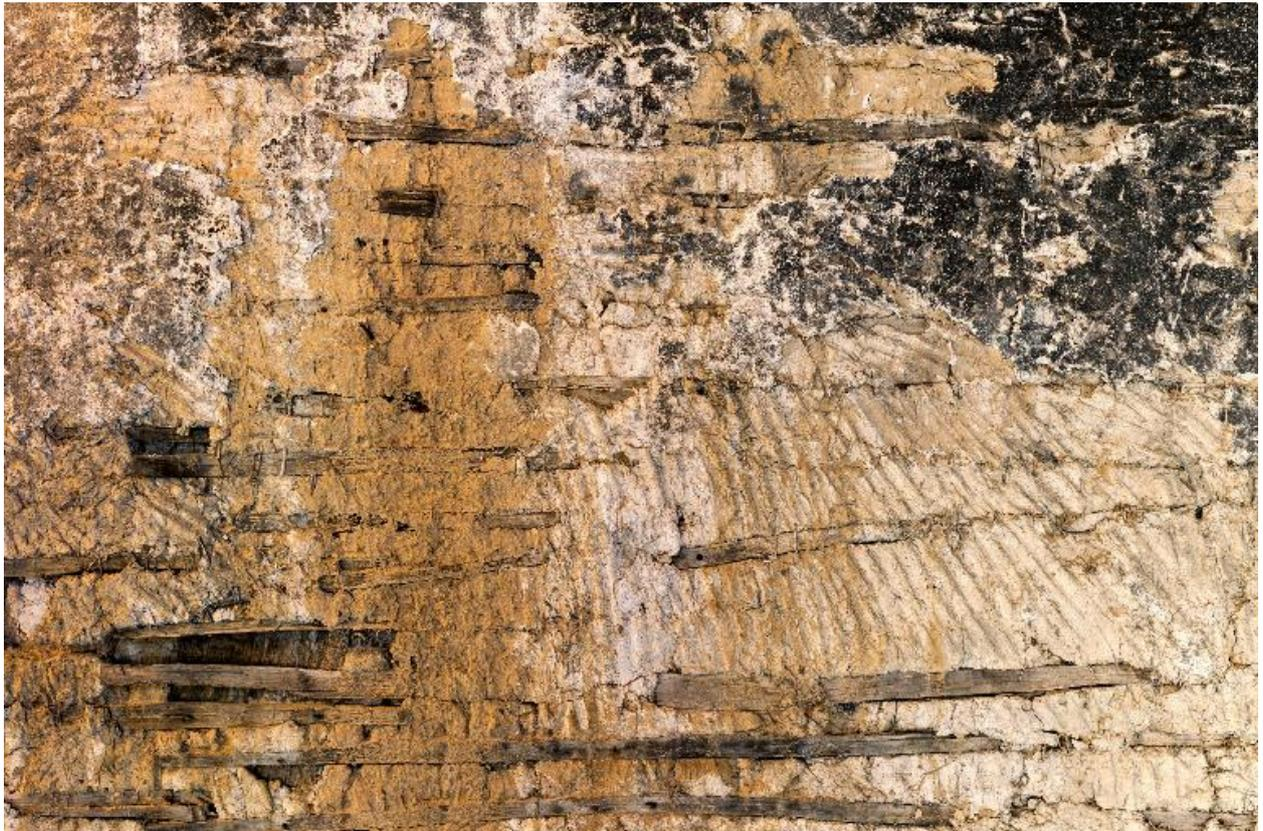
Détail de la face interne du hourdis de torchis du logement, rainurée pour permettre l'accroche de l'enduit.
