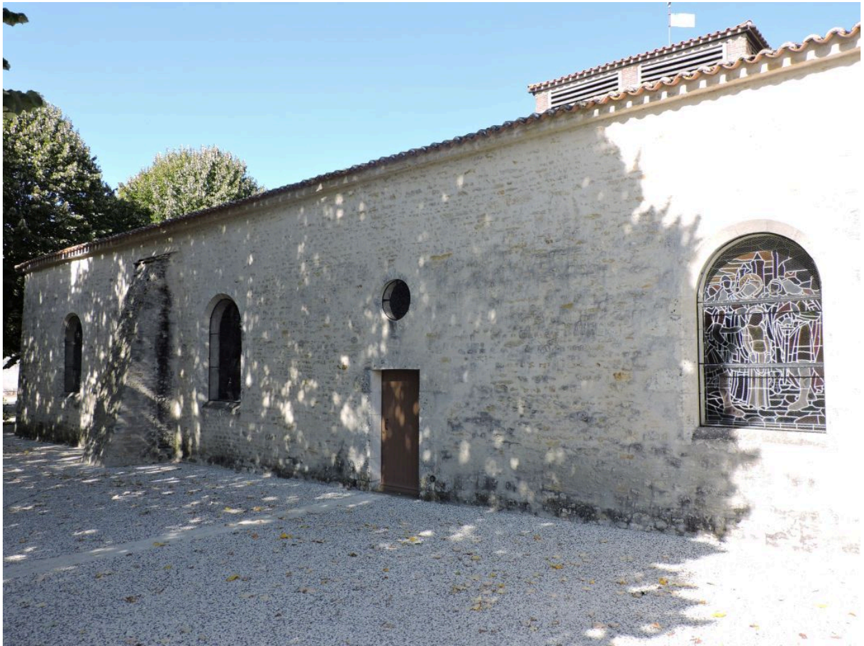
Le mur sud de la nef et ses ouvertures.
