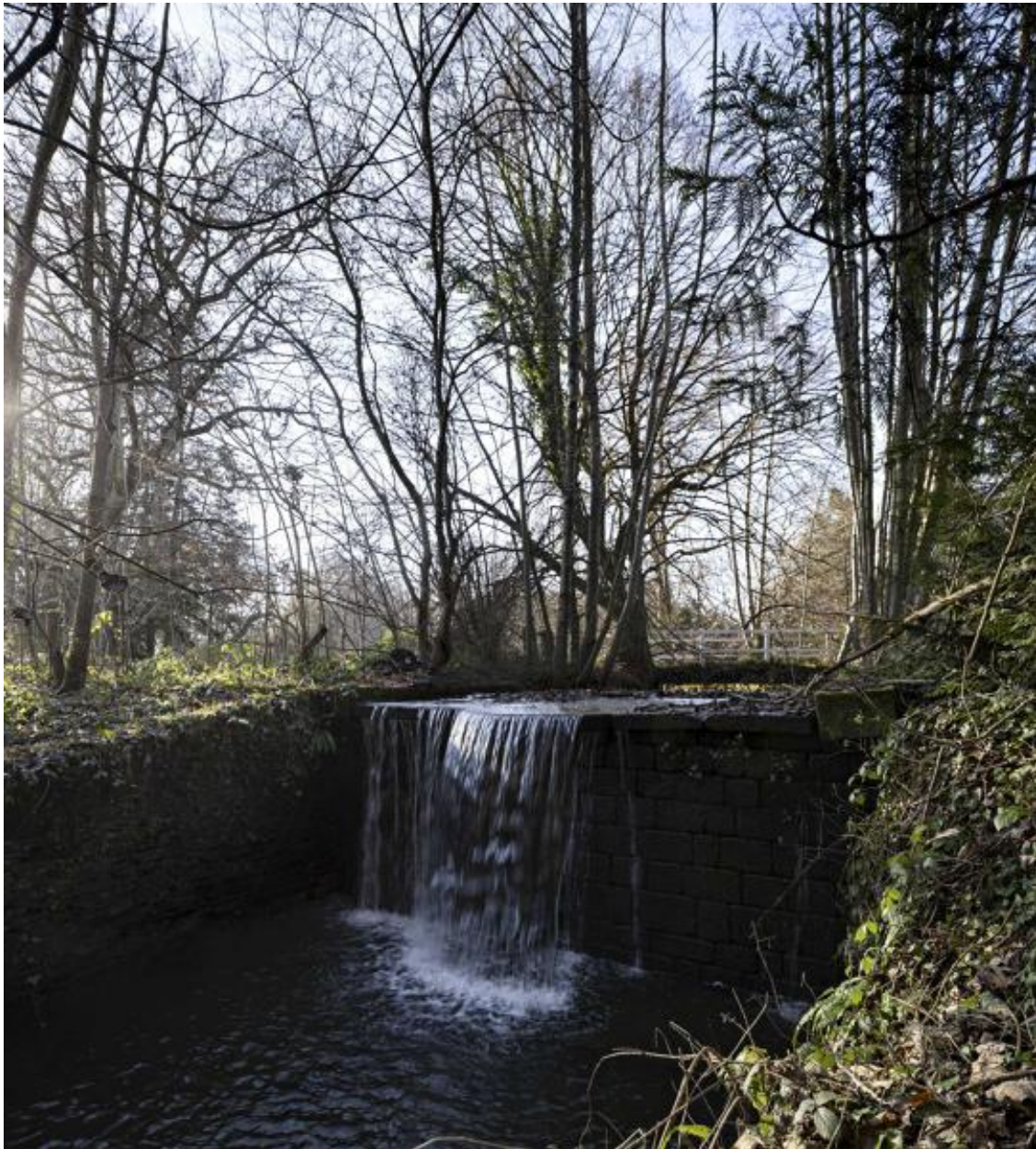
Digue sur le cours d'eau.
