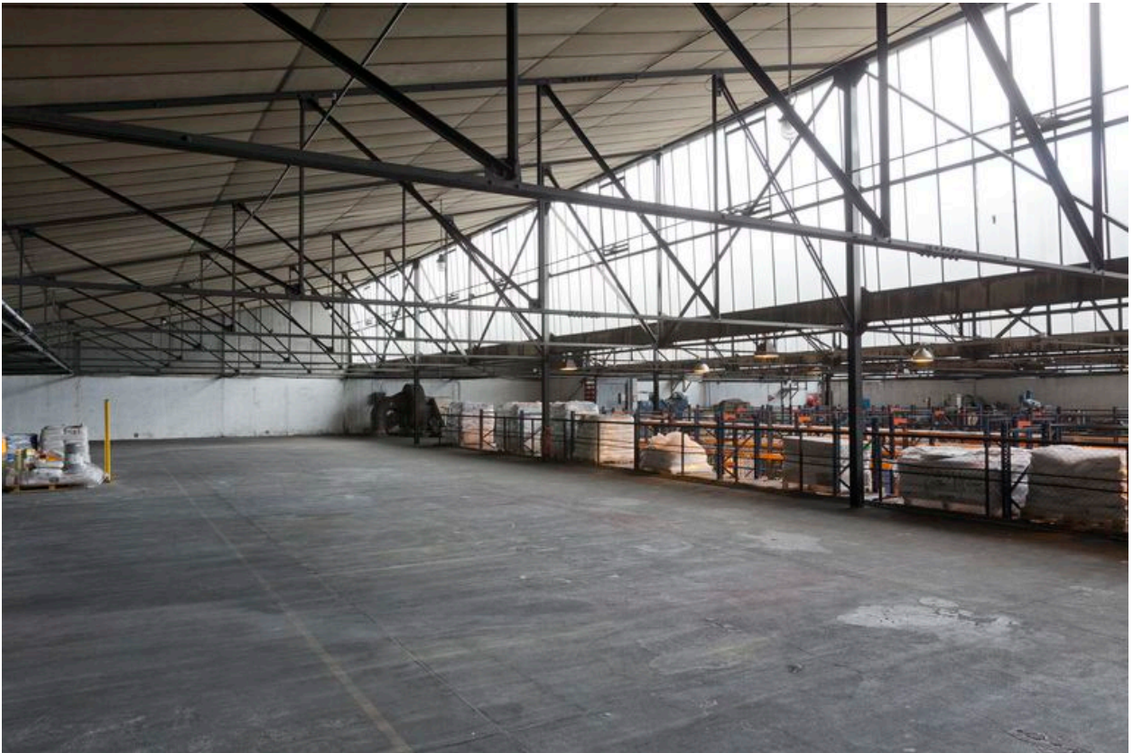
Charpente métallique du magasin général construit entre 1960 et 1956.
