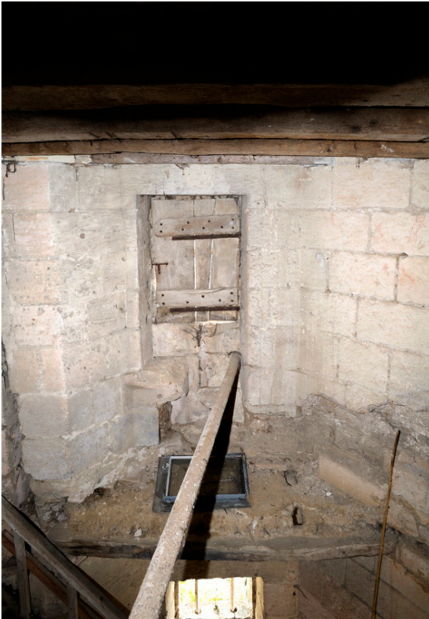
Tourelle d'escalier. Niveau intermédiaire entre l'étage et le comble. Fenêtre à coussiège.
