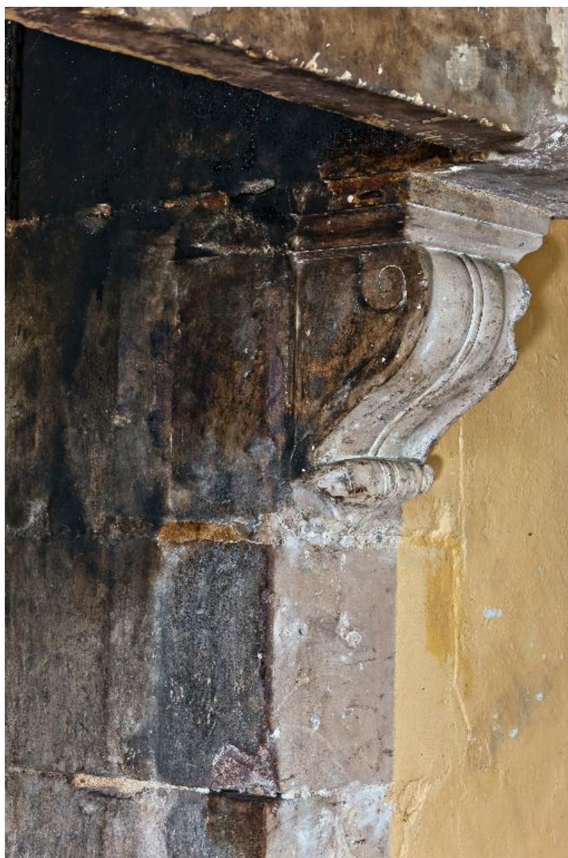
Détail de la cheminée.
