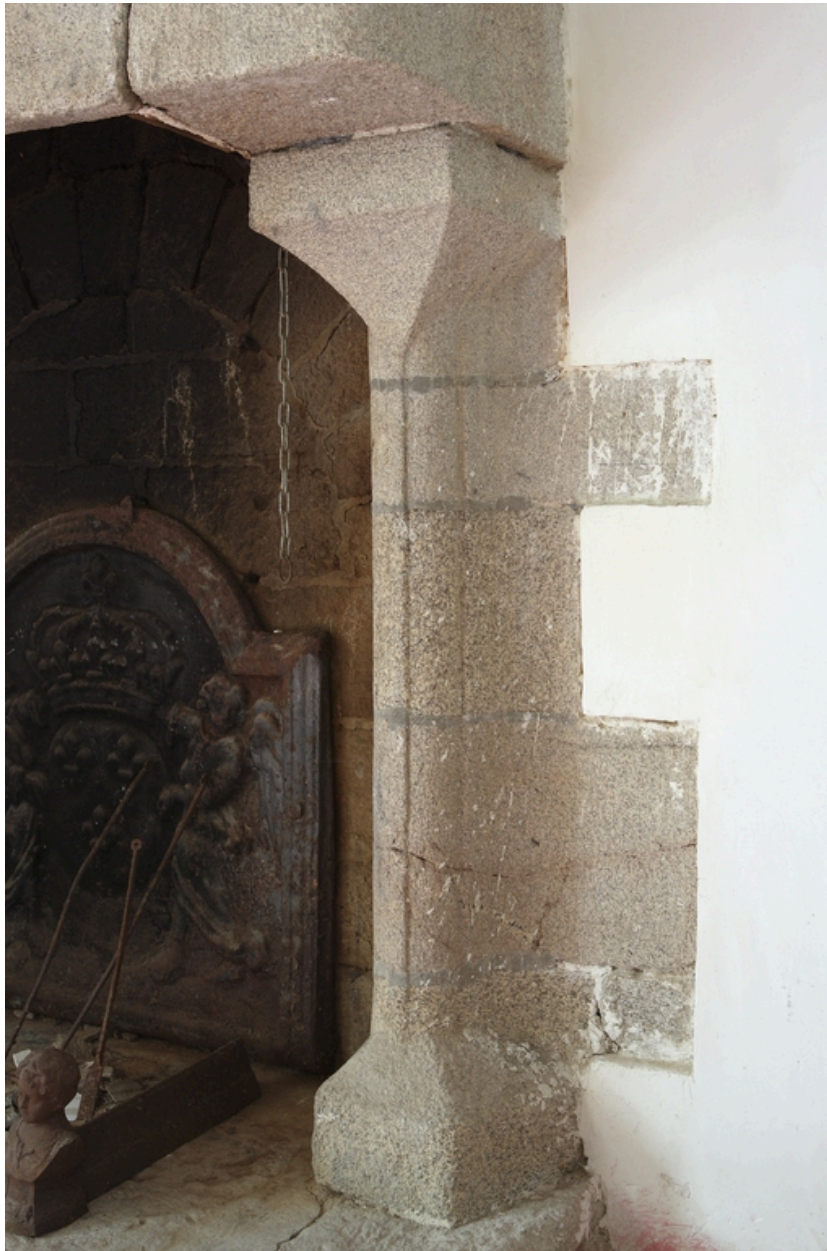
Logis. Aile nord. 1er étage. Détail du piedroit de droite de la cheminée.
