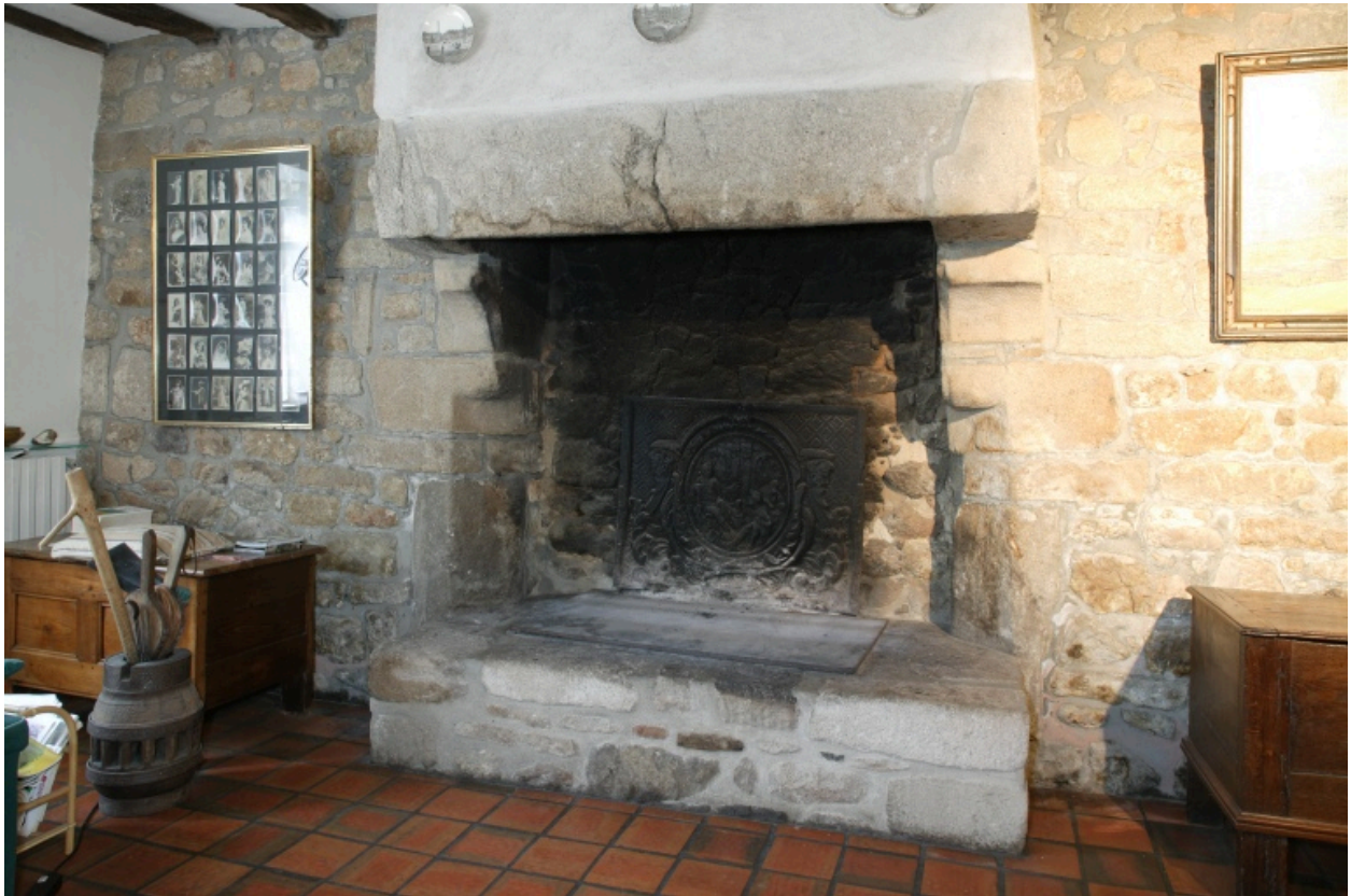
Cheminée, pignon ouest.
