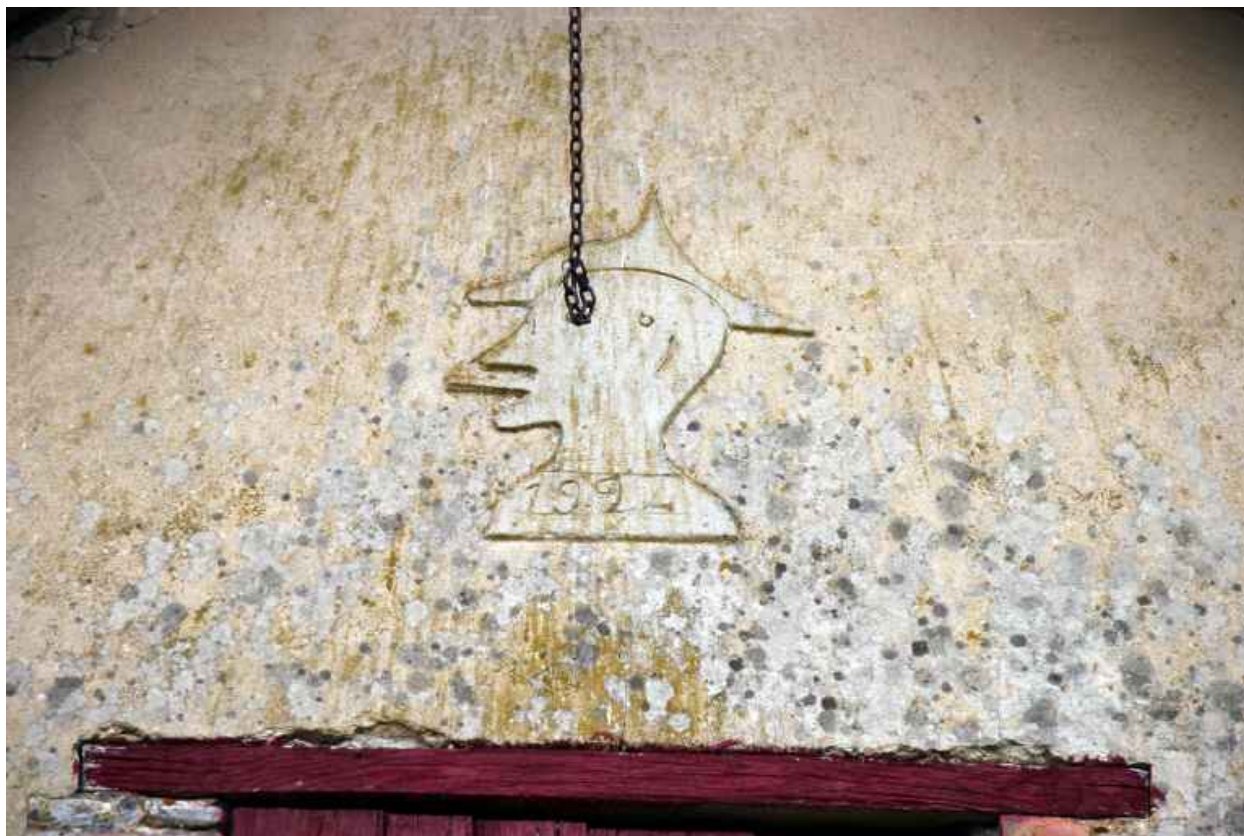
Pignon de la maison portant la date 1922.
