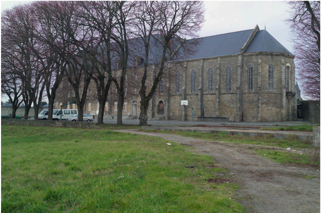
Vue générale de la façade orientale.
