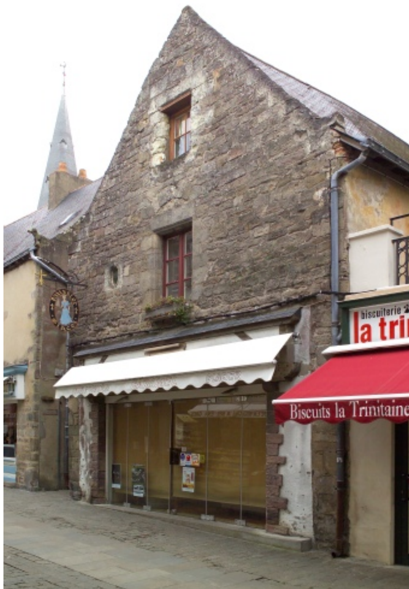
Vue de la façade à pignon.
