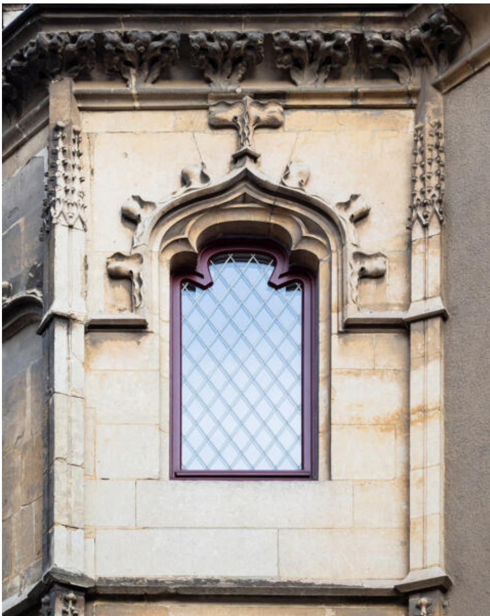
Vue de la fenêtre en partie supérieure de la tour latérale.
