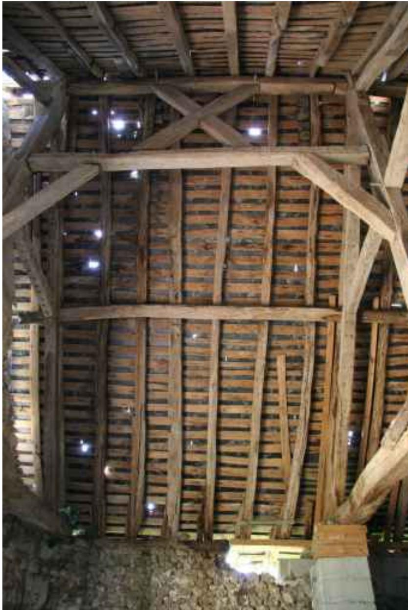
La grange : travée de la charpente avec sous-faîtage.
