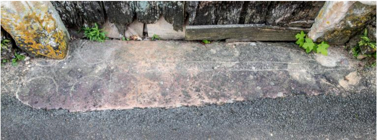
Le seuil de la chapelle, côté rue.
