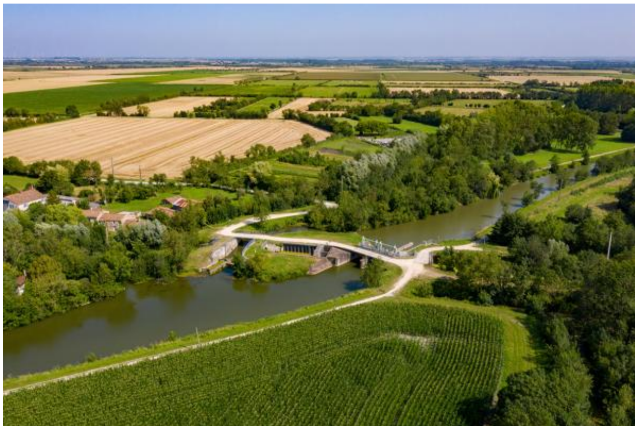
Vue aérienne de l'aqueduc depuis le sud.
