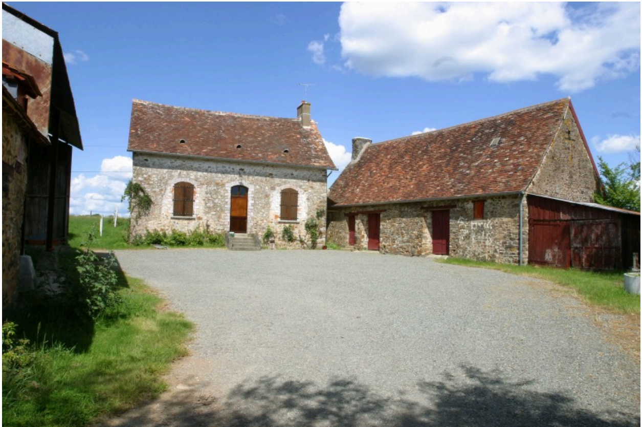
Vue depuis la cour au sud : logis et ancien logis-étable.
