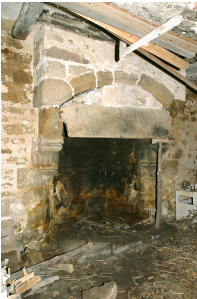
Cheminée au rez-de-chaussée de l'aile nord.
