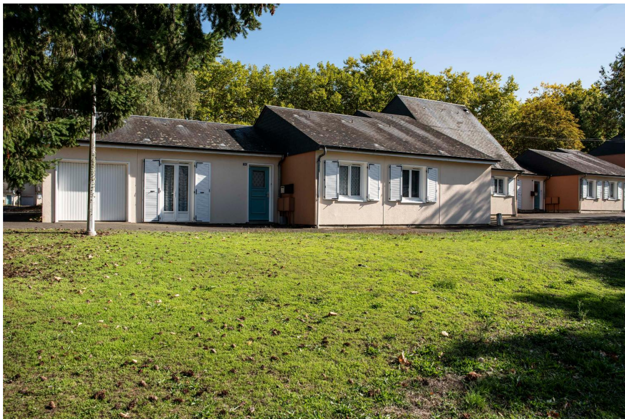
Vue des maisons cour des frênes.
