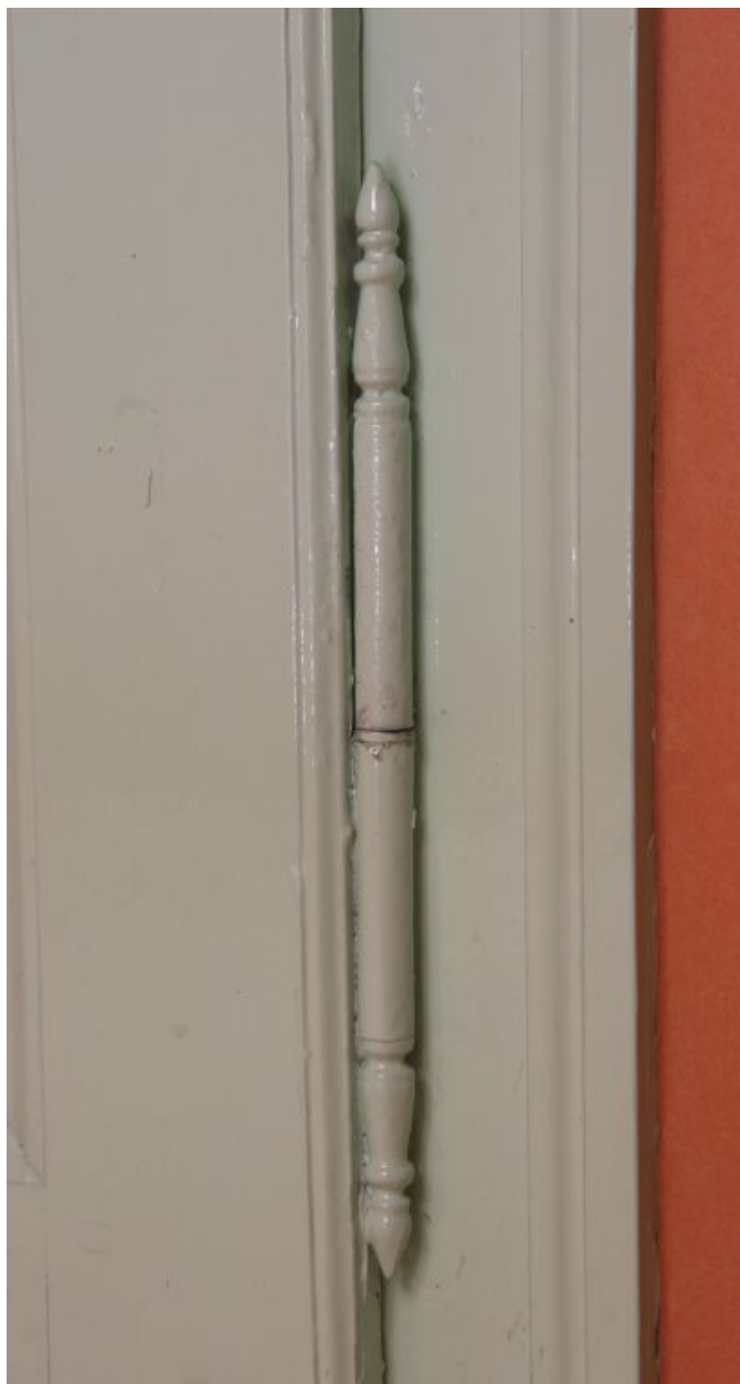
1er étage, chambre au dessus de la cuisine, seconde porte : détail.
