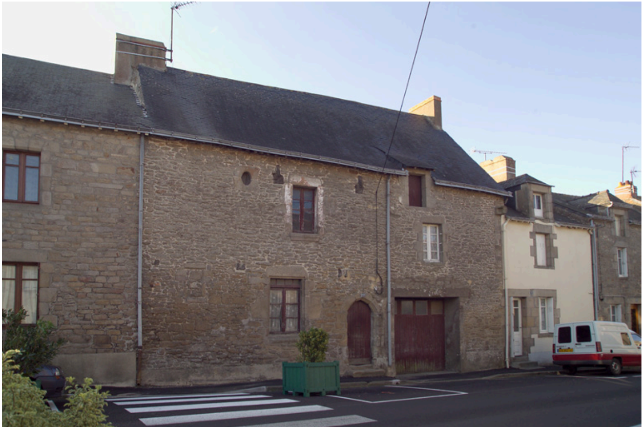
Corps principal, façade nord, vue générale.
