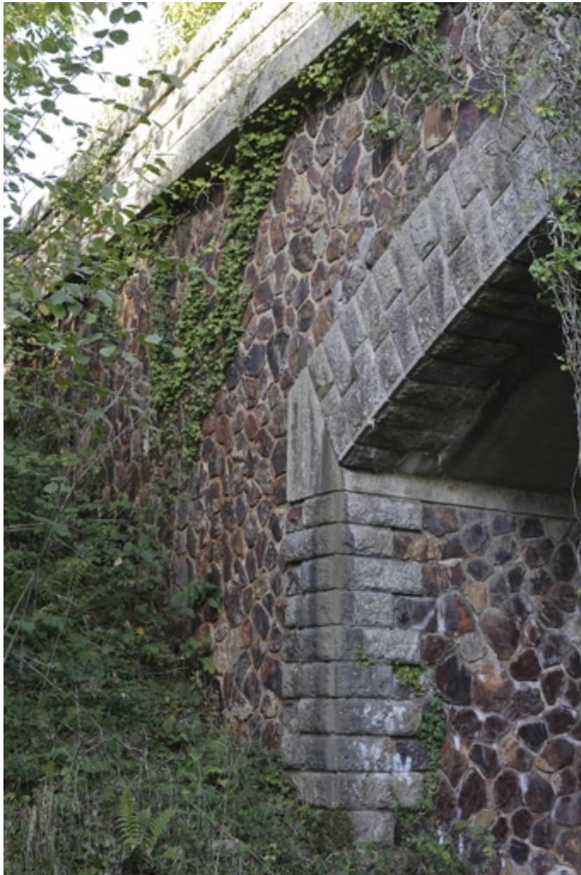
Détail des maçonneries.
