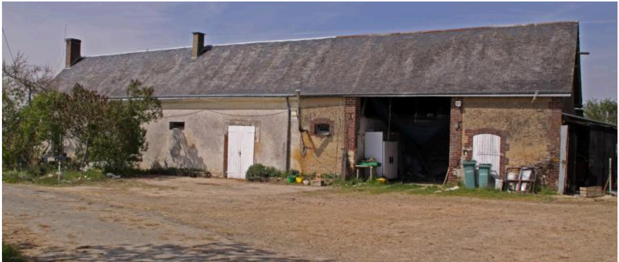
Vue d'ensemble prise depuis le sud.
