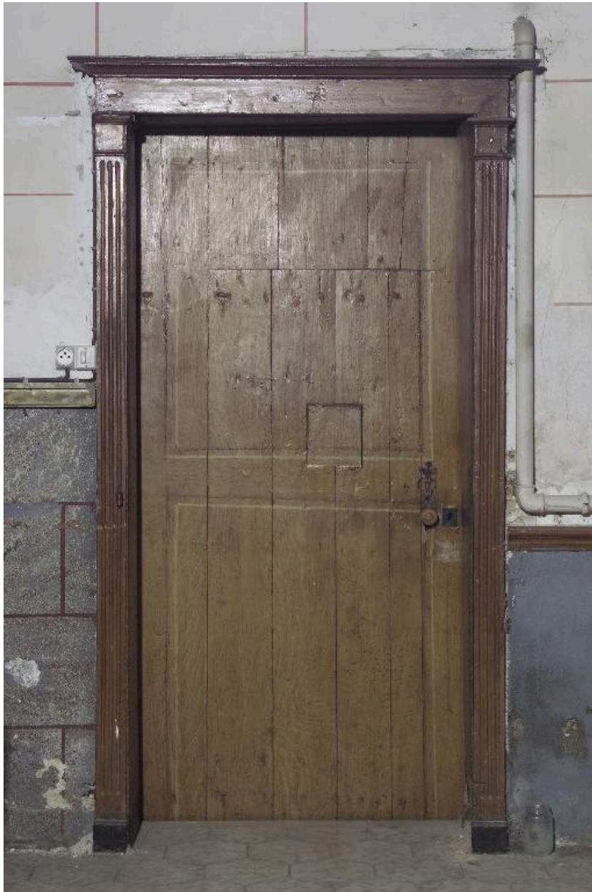
Porte située à droite du chœur.
