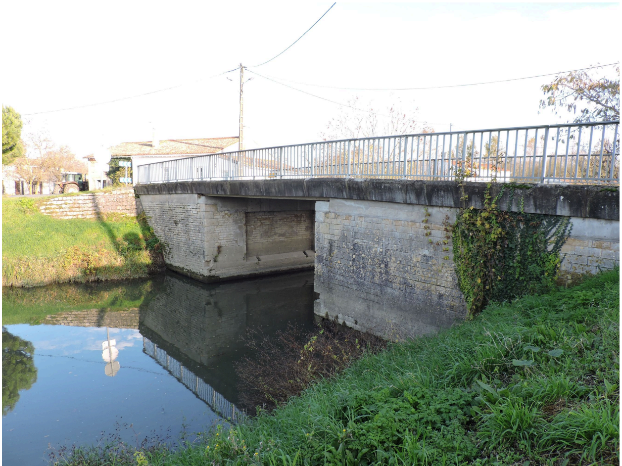
Le petit pont nord vu depuis le sud-ouest, côté aval.
