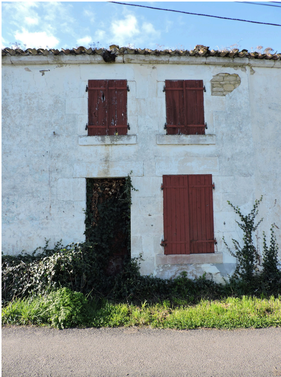
Deux travées d'ouvertures d'un des logements.
