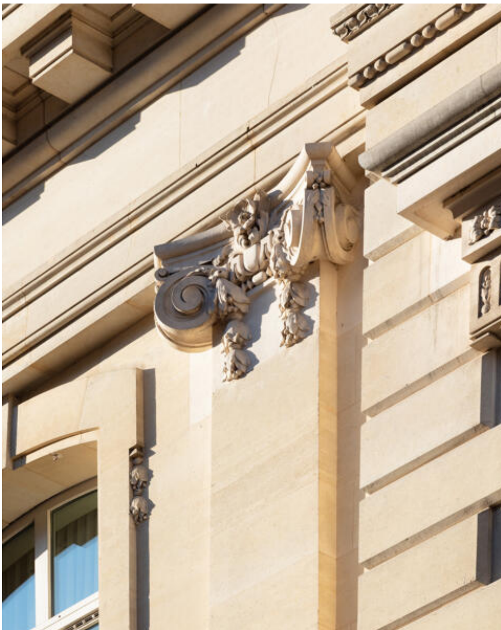
Détail du chapiteau d'un pilastre sur la façade du bâtiment principal rue Chanzy.
