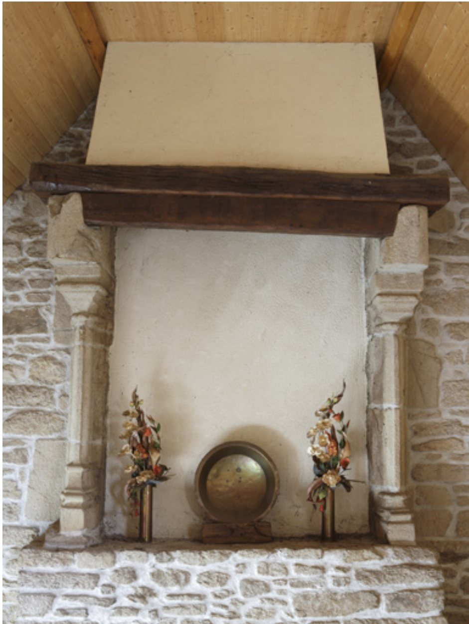
Logis. Vue de la cheminée de l'étage.
