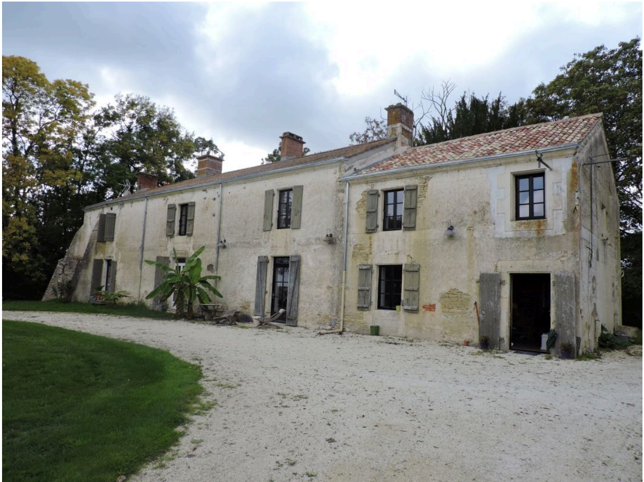
Le logis vu depuis l'est.
