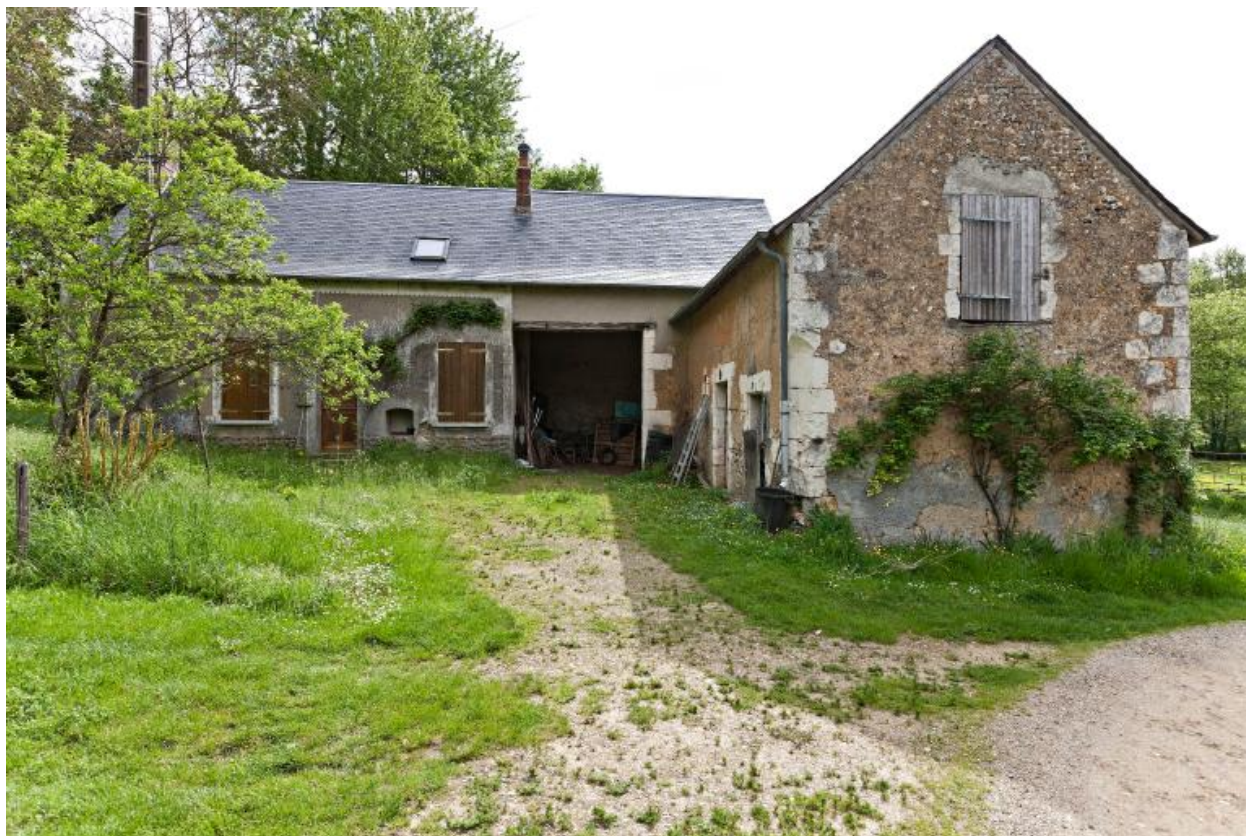
Ferme en L, vue depuis l'ouest.
