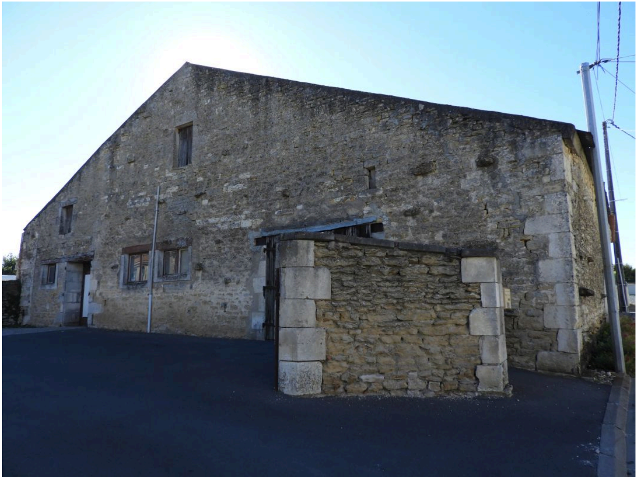
La grange-étable vue depuis le nord-ouest.
