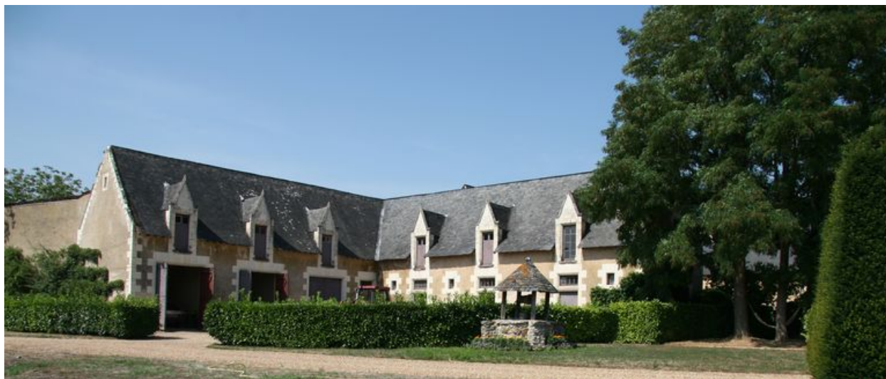
Remises et écuries construites par E. Dainville.
