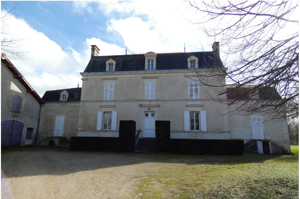
La façade nord de la maison de maître.
