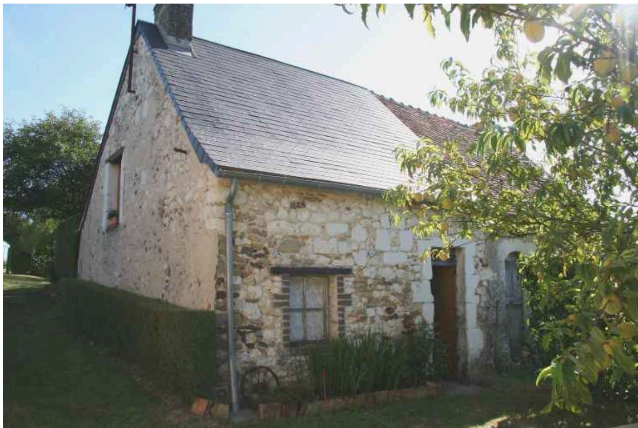
Maison 2 : façade antérieure.
