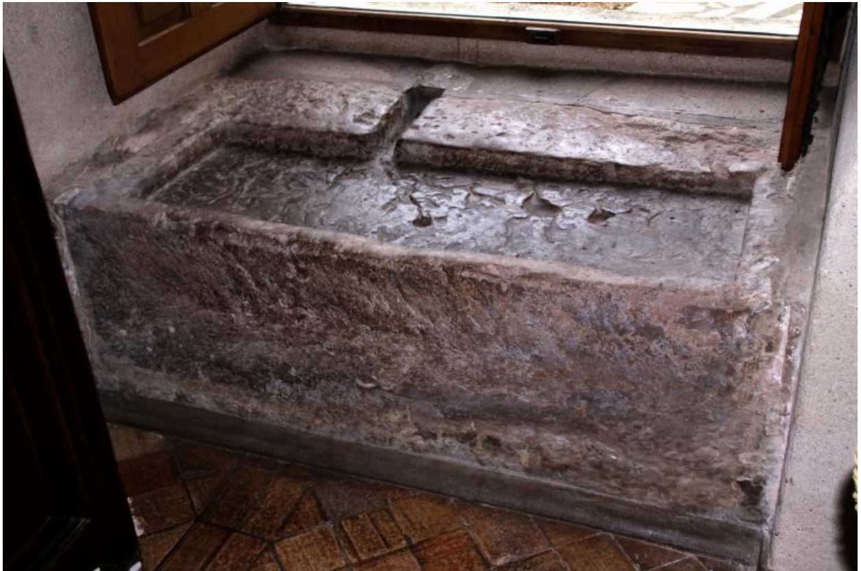
Logis, rez-de-chaussée, grande salle : détail d'un évier.
