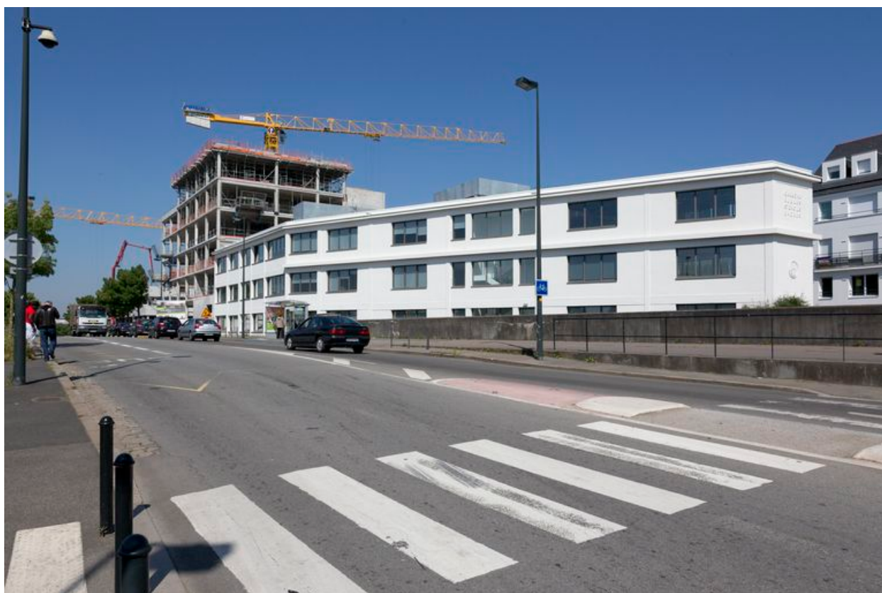
Pointe d'Armor réhabilitée, 2013.
